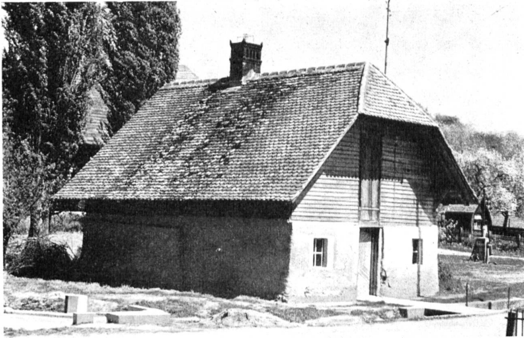
Abb. 1. Das Backhaus von Galmiz, Umbau neu.
