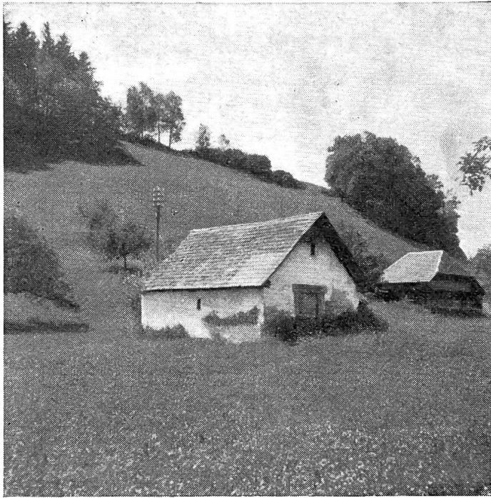
Abb. 3. Einraum-Ofenhaus. Steinbau (Typ Nr. 1, s. S. 77). Reiner ursprünglicher Typ (mit Ausnahme der früher nicht üblichen Dachziegel) ohne Fenster, nur mit Licht- und Rauchschlitzen. Ofenhausverzeichnis Nr. 118.
