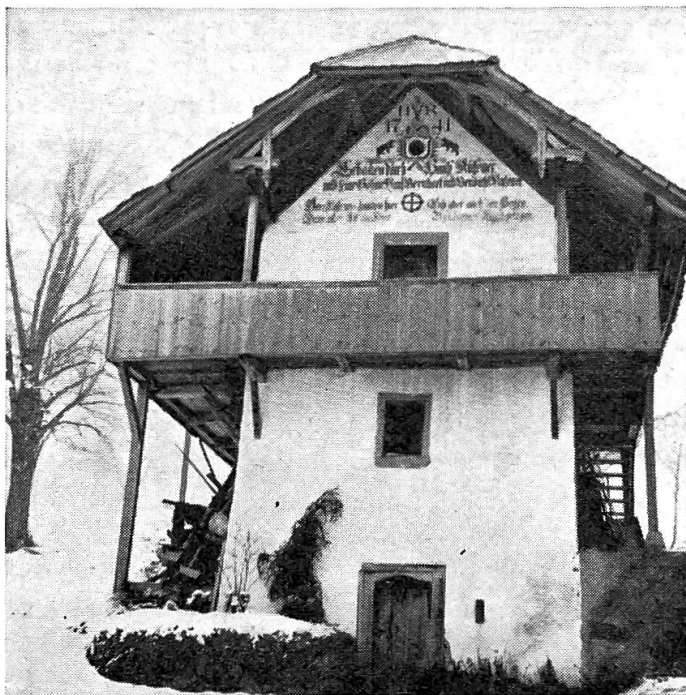
Abb. 5. Ofenhaus (Typ 5, s. S. 77) beinahe turmartig hochgezogen, im Erdgeschoss Tonnenkeller, im ersten Stock Ofenraum (Ofen kürzlich herausgerissen), im zweiten Stock Kornkästen. Blumenstein, dat. 1741. Ofenhausverzeichnis Nr. 18.
