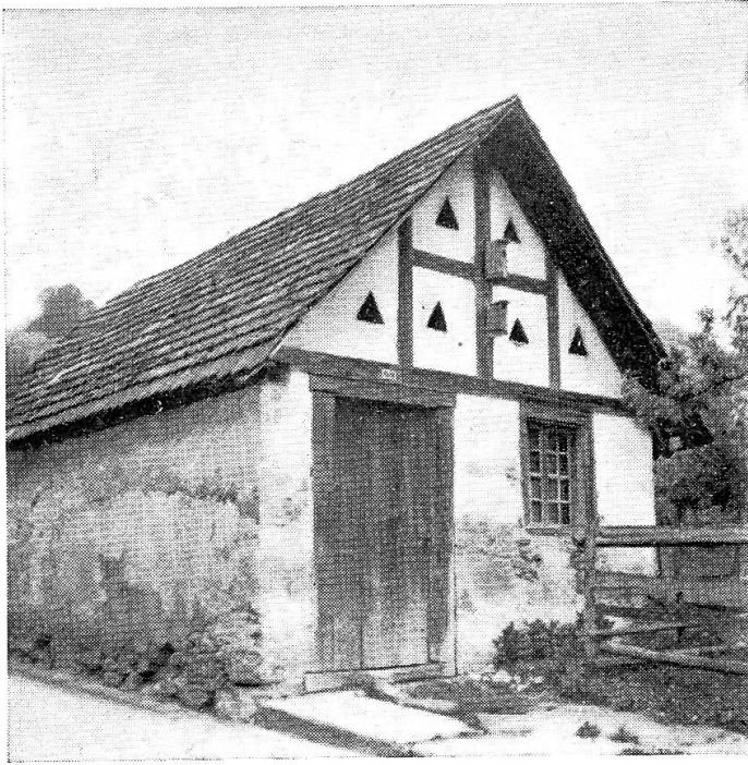
Abb. 6. Ofenhaus. Einfacher Mischtyp. Verbindung des Steinbaues mit Fachwerkgiebel. Gerzensee. Ofenhausverzeichnis Nr. 49.
