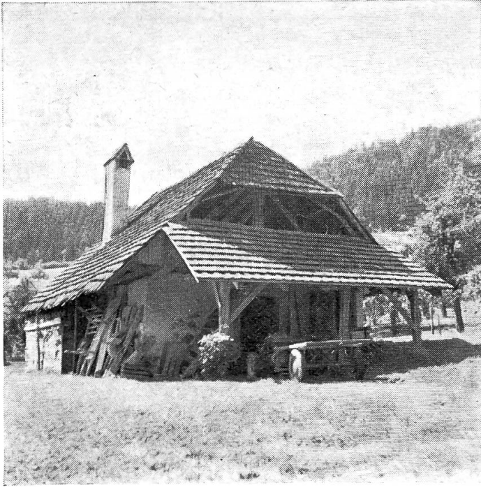
Abb. 7. Ofenhaus mit mehreren Mischungen: Steinbau mit Winkelstrebgiebel, Krüppelwalm- und Vordach. Brenzikofen, dat. 1748. Ofenhausverzeichnis Nr. 55.
