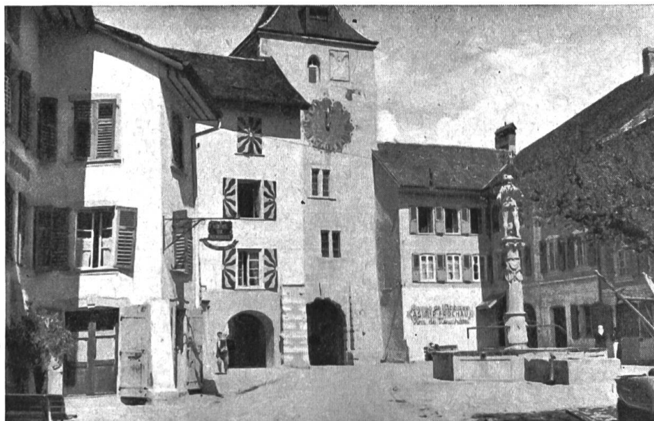
Photo A. Acquadro, Neuveville.
