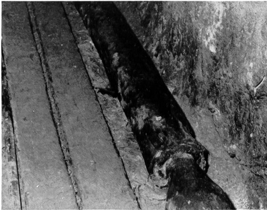
Fig. 1: Photographié dans la galerie de l'étage du Coulat des mines de sel vaudoises: bourneaux emboîtés; à gauche: planches épaisses servant de rails aux wagonnets d'extraction.
