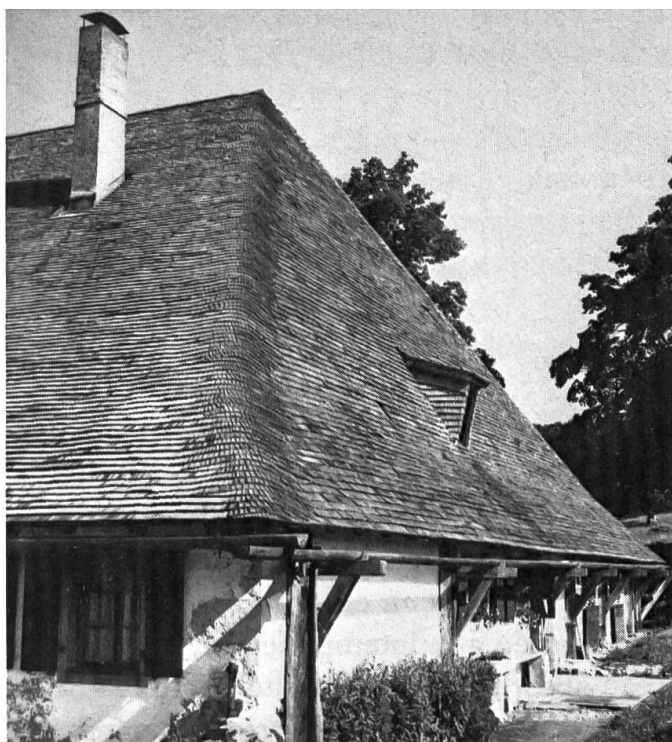
Fig. 27 La Redalle (c. de Provence). Couverture en tavillons refaite en 1981.
