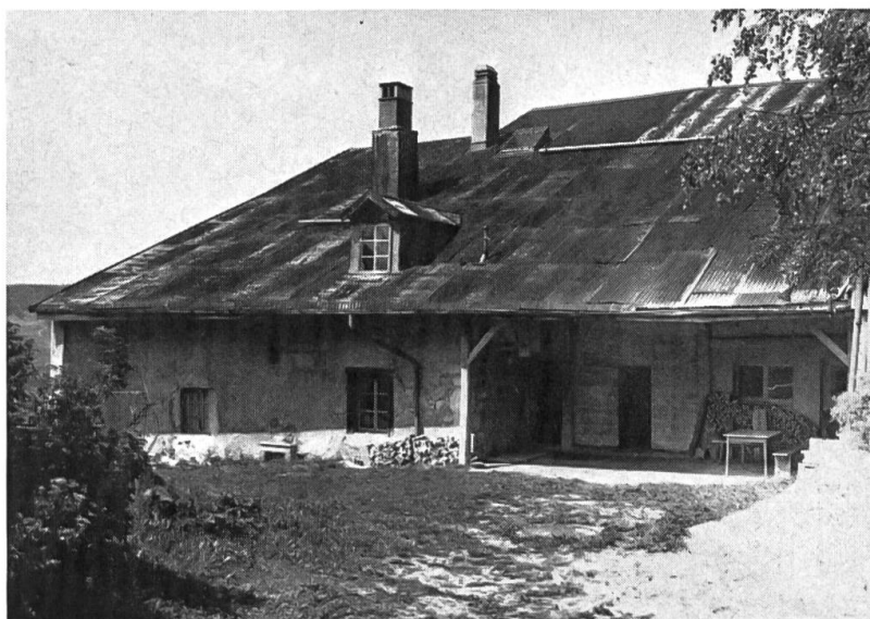
Fig.11 Mont-du-Lac (c. de l'Abbaye). Le logement se trouve au Sud-Ouest; une partie couverte appelée «néveau» occupe le devant de la grange-Fourragère et de l'écurie; la porte du couloir d'accès, l'«allée», donne également sous le «néveau».
