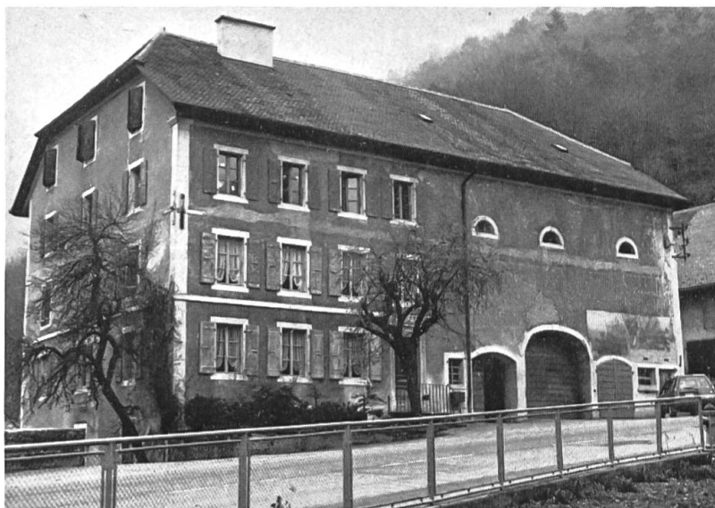
Fig. 16 Vuitebœuf. Ferme à trois étages construite en 1860.
