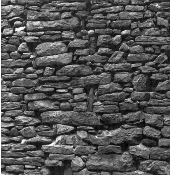
Fig. 22 Onnens. Exemple de maçonnerie de pierres constituée par des pierres plates soigneusement empilées. A l'origine, le mur devait être recouvert par un crépi.
