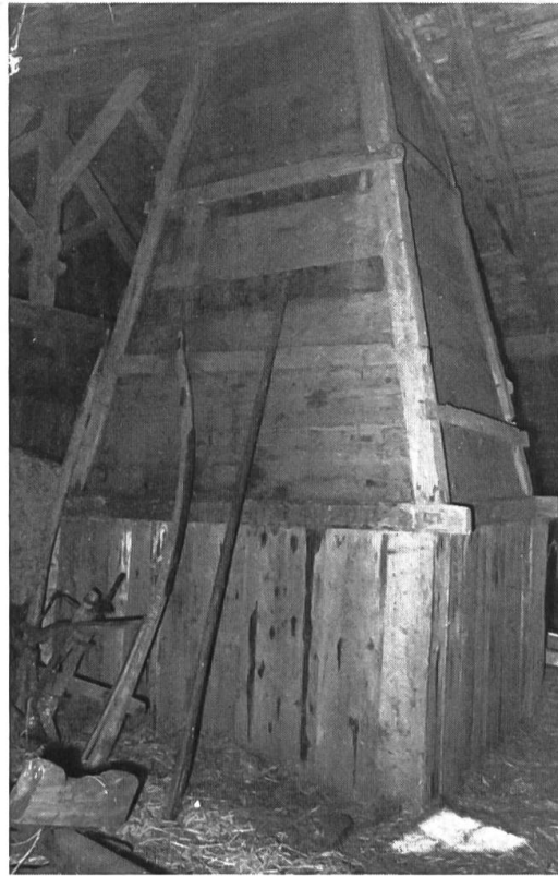
Fig. 30 Mollards-sur-le-Brassus (c. du Chenit). Hotte de cheminée en bois («borne») vue depuis la grange.
