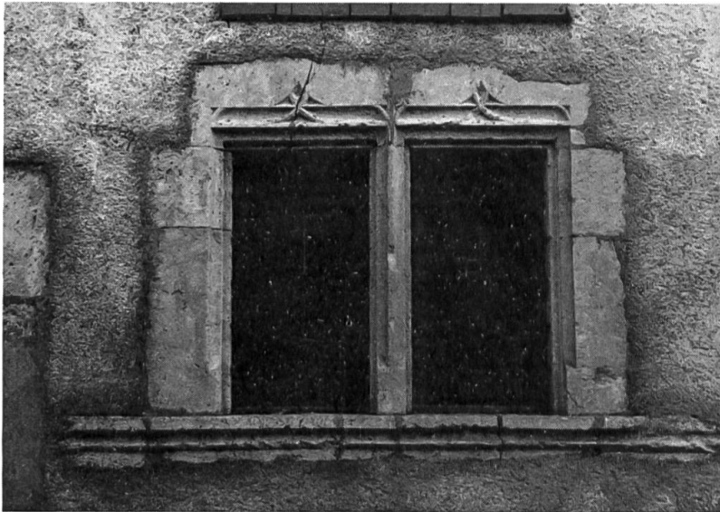
Fig. 26 Bofflens. Fenêtre à meneaux décoré de moulure et de linteaux en forme d'arc infléchi (XVI e siècle).
