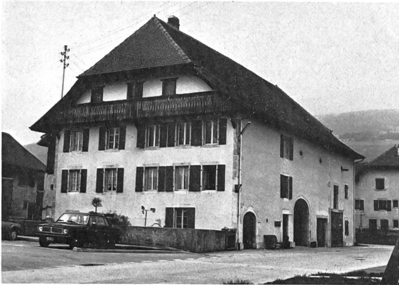
Fig. 17 Bonvillars. Ferme vigneronne avec pressoir et cave au-dessous de la partie occupée par le logement.
