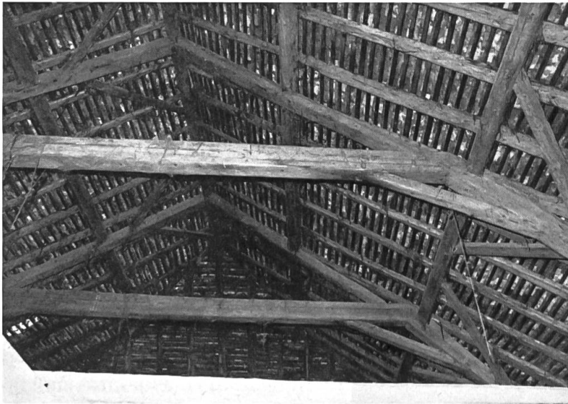
Fig. 34 Vugelles-la-Mothe. Exemple de charpente à tirants.
