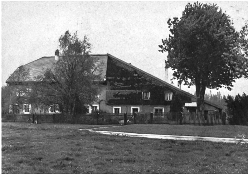
Fig. 10 La Chaux (c. de Sainte-Croix). Ferme de variante intermédiaire combinant les deux cas précédents (ferme à pignon frontal à l'origine dont l'une des moitiés, correspondant à une propriété, a été retournée).
