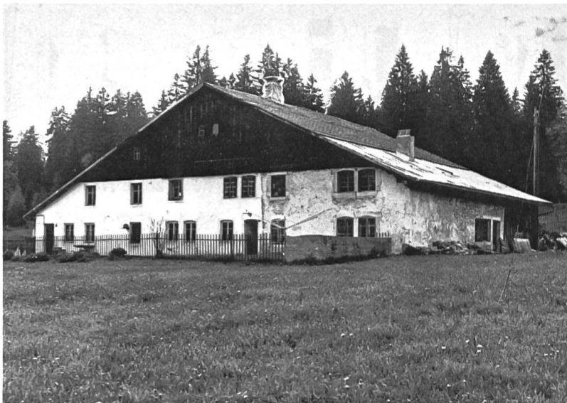
Fig. 8 Vers-Chez-Henri (c. de Sainte-Croix). Exemple de ferme à pignon frontal. La façade principale se trouve sous le pignon et regarde au Sud-Est. La ligne de faîte du toit est perpendiculaire aux courbes de niveau du terrain.
