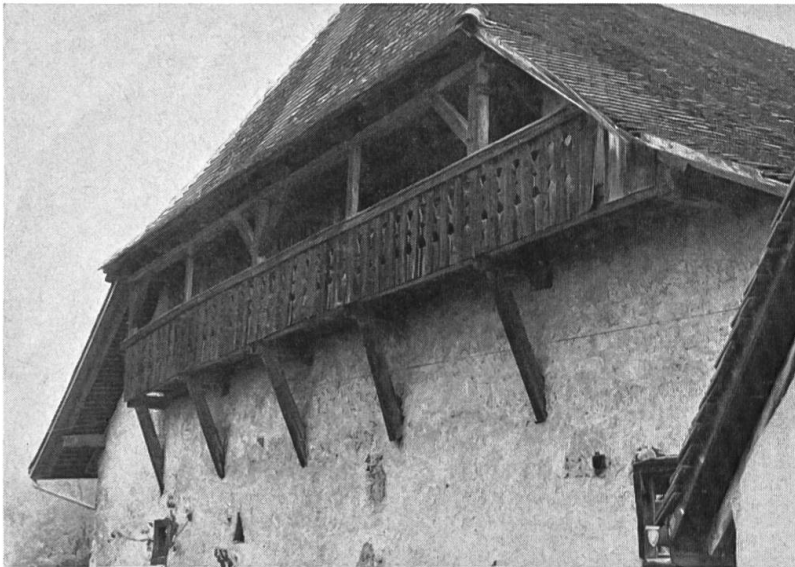
Fig. 18 La Russille (c. des Clées). Galerie formant saillie sur la façade et supportée en partie par des bras.
