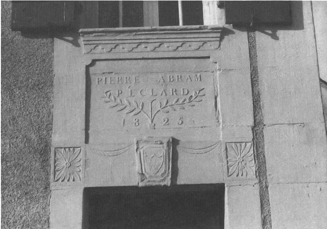
Fig. 5 Pailly (cad. 70), logement de 1825, maçon Charles-Victor Chaillet; le dessus de porte est un lieu privilégié pour la décoration. Sur celui-ci figurent la date de construction, le nom du propriétaire et une plante en pot. Au-dessous, le linteau est orné, en son centre, d'un écusson vaudois et, à ses extrémités, de deux rosaces, reliées à la clé saillante par une draperie assez schématique, ces deux derniers motifs étant issus du répertoire du style Louis XVI, mais transposés dans le langage populaire. Ainsi, les rosaces ont plutôt l'air de marguerites.
