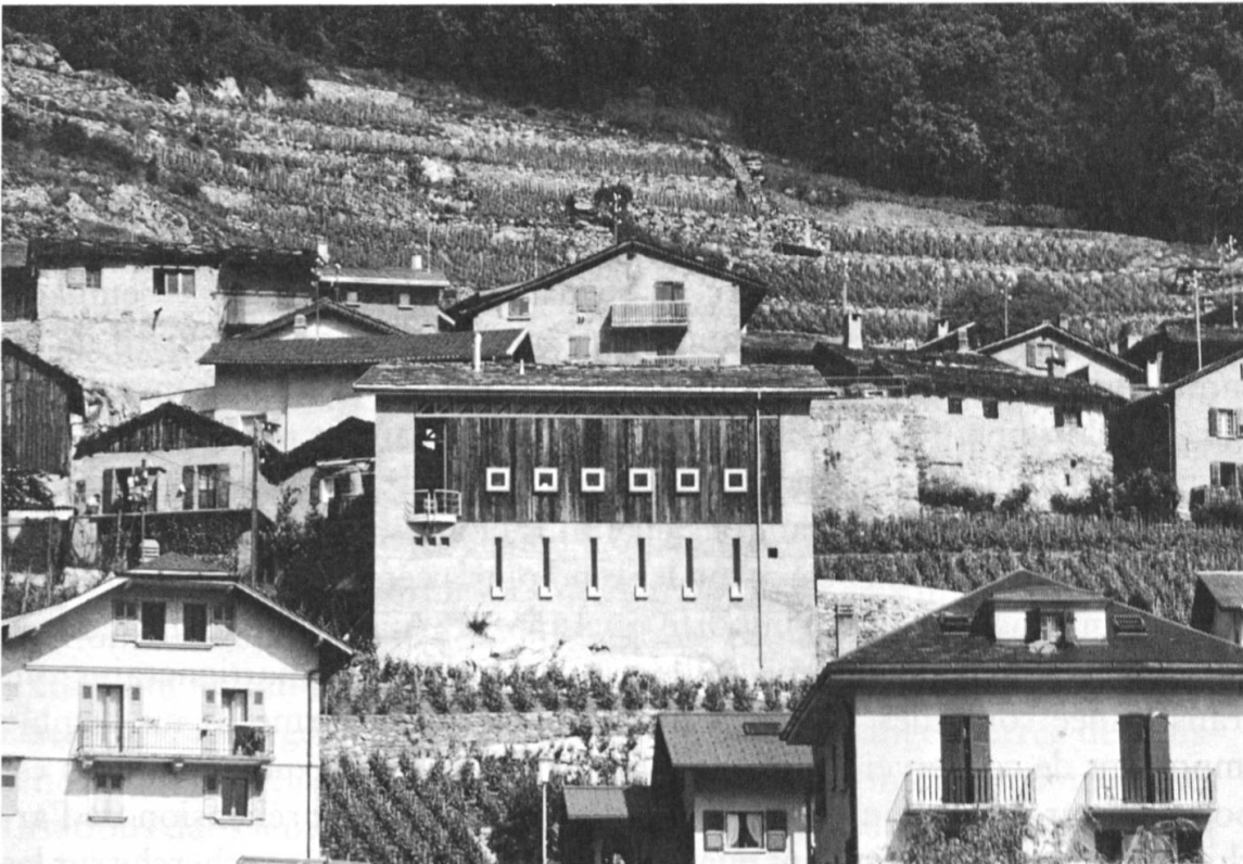
Fig. 4: Grange-écurie: après transformation (Chabbey et Voillat).
