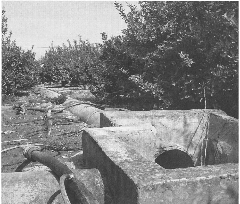
Direkte Bewässerung der einzelnen Orangenbäume über Haupt- und Nebenleitungen (Betonröhren, Wasserschläuche).
