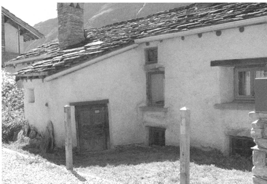
Renoviertes Haus mit neuem Fenster, alter Steinplattenbedachung und den eingetieften Fensteröffnungen der einstigen Stallwohnungen, das möglicherweise als Ferienwohnung einer binnenemigrierten Familie dient.
