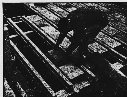
Betonbalken-Decke System Ottiker
