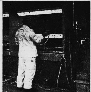
Modernste Farbspritzkabine mit Wasservorhang
