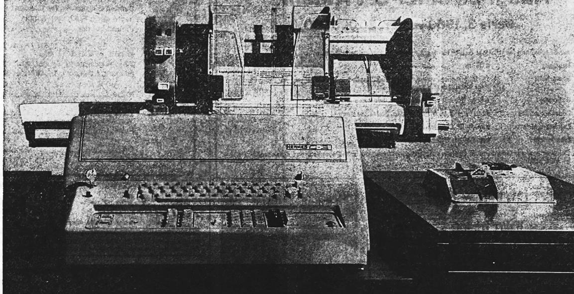
HERMES C-3, Buchungsautomaten nach Mass, können von 3 bis zu 11 Rechenwerken ausgebaut werden. Sie sind mit Volltext und, sofern erwünscht, mit Kurztext-Tastatur ausgerüstet. Aussergewöhnliche Vielseitigkeit durch Steuerschienen mit 4 und Tabulatorschiene mit 8 Programmen. — Besonders praktisch und wirtschaftlich ist die HERMES C-3 mit Monomatic- oder Bimatic-Einzugsautomaten. Mit angeschlossenen Streifen- oder Kartenlocher steht die HERMES C-3 im Dienste der Datenverarbeitung.
