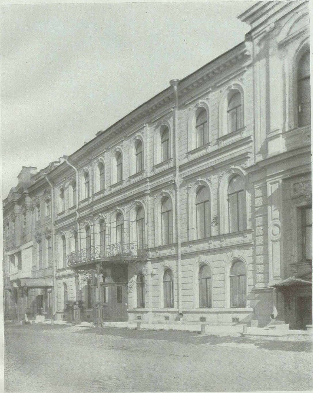
Bauten von Bernhard Simon: Haus der Fürstin Radziville am Quai der Neva.
