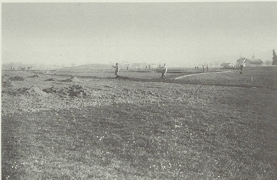
Für den Bau eines Flugplatzes auf dem Breitfeld mussten in einer ersten Bauetappe vom Oktober bis in den Dezember 1924 Planierungsarbeiten ausgeführt werden. Bauarchiv St.Gallen.
