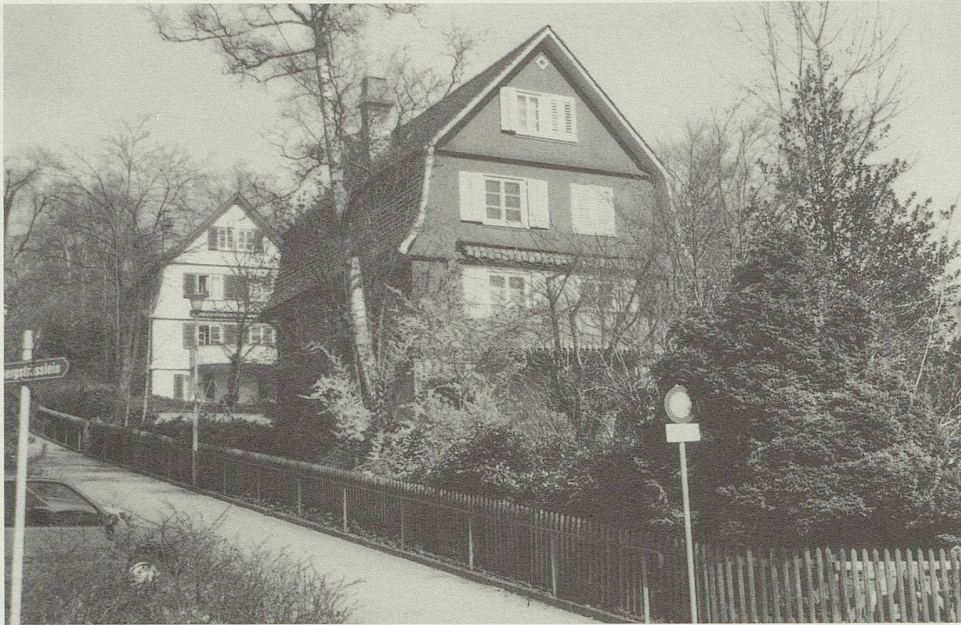
Teil des 1929 von der Firma Hector Schlatter & Cie. erstellten Einfamilienhaus-Ensembles am östlichen Rosenberg, und zwar die Liegenschaften Herderstrasse 1 und im Hintergrund Wartensteinstrasse 6. Photo von Astrid Haller-Vogel.
