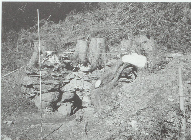
Abb. 8. Alt St.Johann, Blüemlisholz. Ansicht des Kalkofens mit erhaltenem Feuerungsloch. Eine Informationstafel des Kulturwanderwegs soll Funktion und Bedeutung der Kalkbrennerei im Obertoggenburg erklären. Foto KA SG.
