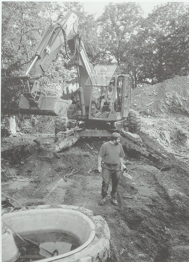
Abb. 15. Voraushub durch die Kantonsarchäologie vor dem Beginn der Umgebungsarbeiten auf dem Pfäfersbüel. Im Bild dipl.phil. Erwin Rigert. Foto KA SG.
