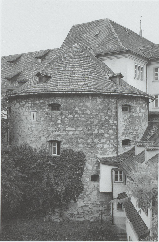
Der runde Turm in der St.Galler Klostermauer. (Foto kant. Denkmalpflege)
