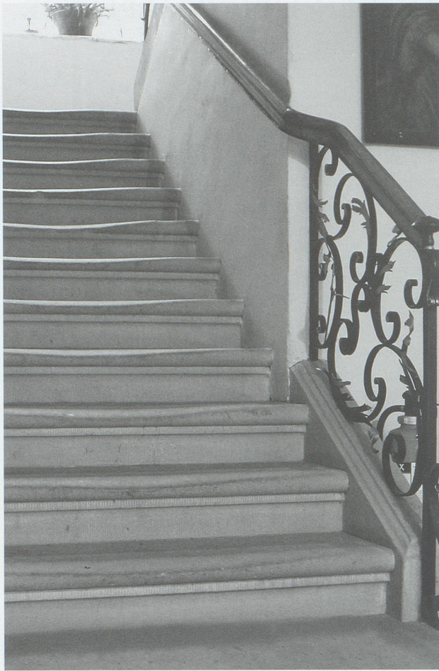
1777 Zeugherr Fridolin Schindler, 1791 Kaufmann Jacob Laurenz Custer und 2008 alle Besucher des Denkmaltages haben auf den Treppenstufen des Schlosses Balgach ihre Spuren hinterlassen. (Foto kant. Denkmalpflege)
