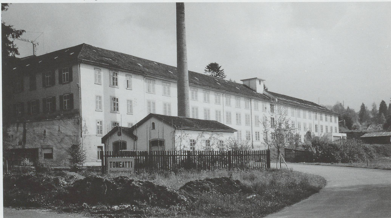
Vertikaler und horizontaler Akzent der ehemaligen Seidenweberei Schubiger in Uznach. (Foto kant. Denkmalpflege)
