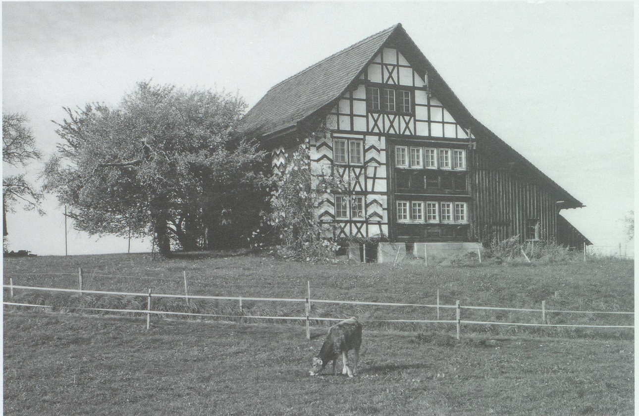
Unterschiedliche Konstruktionsarten: Fachwerkhaus in Wittenbach und Bohlen- ständerbau in Jona. (Fotos kant. Denkmal- pflege)
