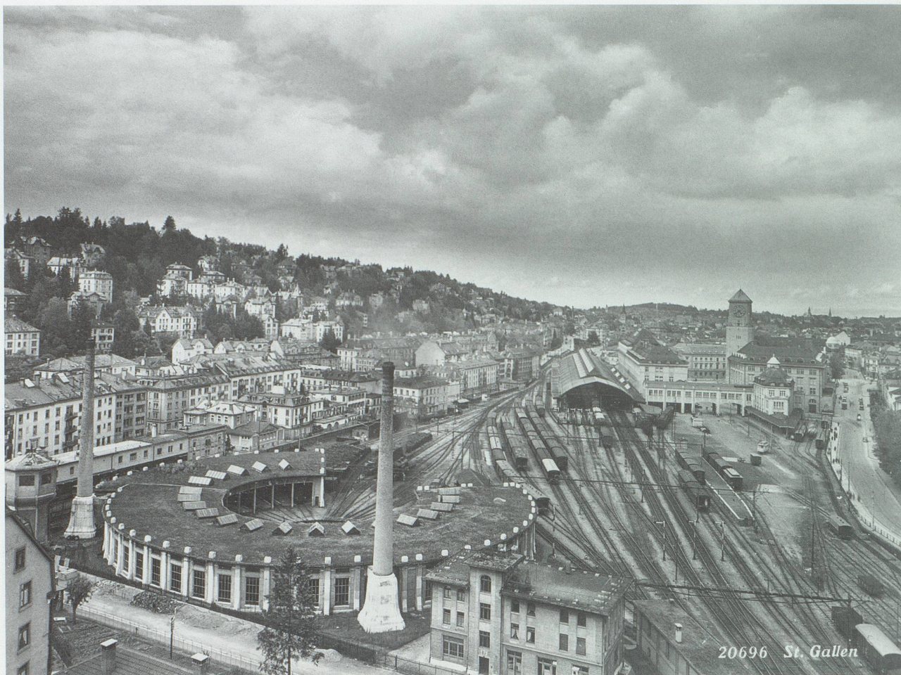
St.Gallen, Aufnahme des Bahnhofgeländes aus dem Jahr 1937 mit der Lokremise und den beiden Hochkaminen (Foto: Foto Gross, St.Gallen).
