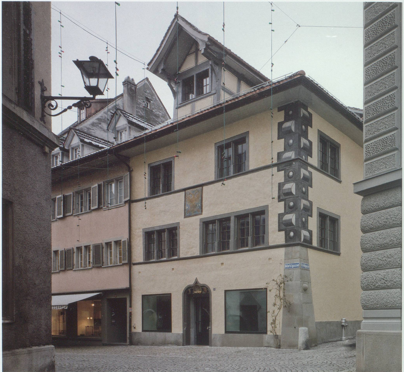
Rapperswil, Marktgasse 4. Leicht abgetöntes, kalkweisses Haus von 1613 mit zeitgenössischer Eckquadrierung und Doppeladler. In der Stadt Rapperswil entdeckte man fast an jedem Haus solche Eckquadrierungen, seltener auch Sockelmalereien mit perspektivischen Würfeln oder einfachen Schachbrett- und Rautenmustern (Foto: Dominique Marc Wehrli, Zürich).
