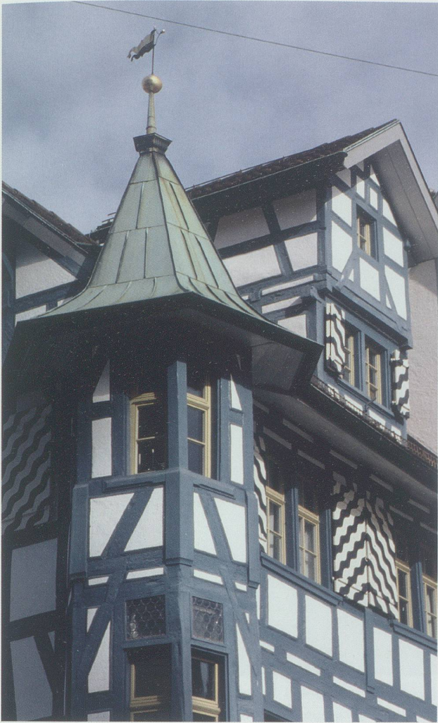
St. Gallen, Gallusstrasse 20, Blaues Haus, blaues Fachwerk mit Smalte. Blau wurde bis ins 18. Jahrhundert nur als überaus teures Pigment des Halbedelsteins Lapislazuli in der Wandmalerei verwendet oder als Smalte (gemahlenes blaues Glas) auch bei Fachwerkbauten. Die Entdeckung des nicht kalkechten Pariserblaus (Preussischblau 18. Jh.), die Fabrikation von Kobaltblau (um 1800) und des säureempfindlichen Ultramarinblaus (um 1836) eröffneten ganz neue Möglichkeiten (Foto: kant. Denkmalpflege).
