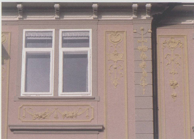
Goldach, Villa Wartegg, erbaut 1903. Rosa Verputz und gelb gefasste Stuckaturen (Fotos: kant. Denkmalpflege).
