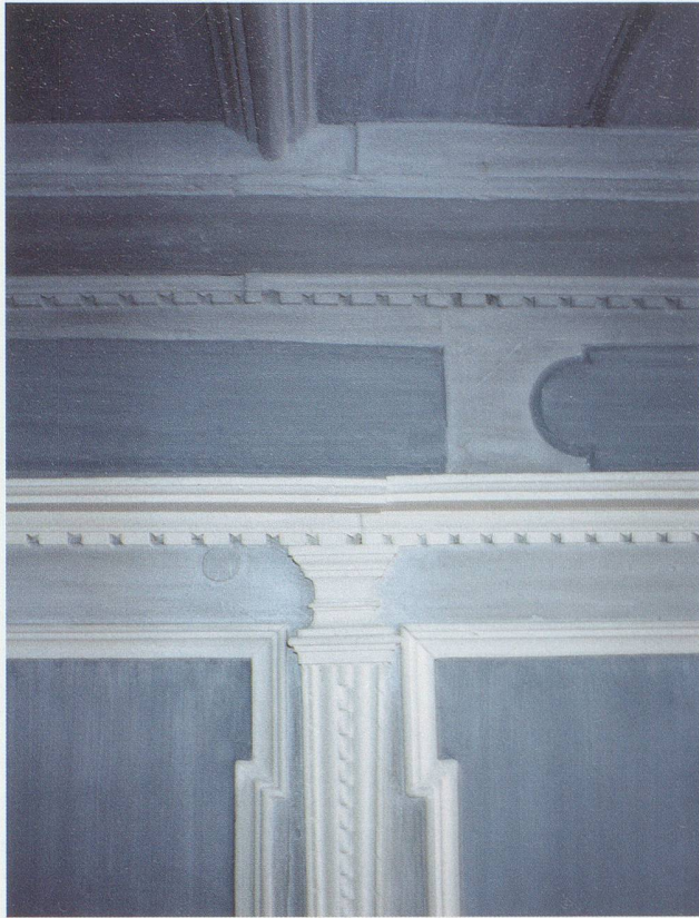
Wil, Kirchgasse 41. Das in seinem Kern spätmittelalterliche Wohnhaus zeigt im dritten Stock eine Renaissance-Stube. Es konnten mehrere, wohl neuere Blaugrau-Fassungen auf dem einst holztonigen Täfer nachgewiesen werden. Der Neuanstrich erfolgte mit einer mehrfach lasierend aufgetragenen Kaseinfarbe. (Foto: kant. Denkmalpflege).
