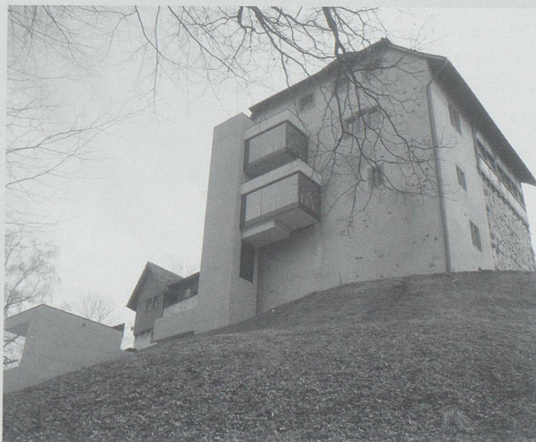
Der neue Aussenlift mit den zwei Glas-Passerellen an der Nordseite vom Schloss Oberberg in Gossau.
