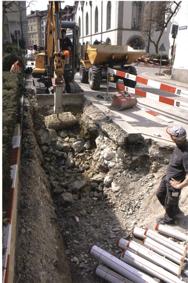
St.Gallen, 2009. Im Trottoir der Zeughausgasse wird ein Grossteil des Fundaments der Schiedmauer für Leitungen weggespitzt. Foto KA SG.
