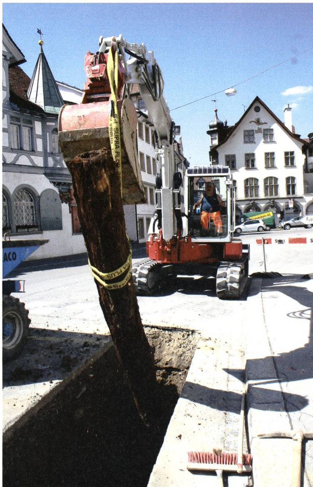
St.Gallen, Gallusstrasse 2008. Ein neuzeitlicher Teuchel wird vom Bagger gehoben. Foto KA SG.
