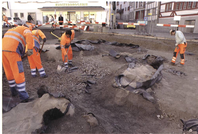
St. Gallen, Gallusplatz 2011. Die Turmreste werden sorgfältig eingekiest und bleiben so erhalten. Foto KA SG.
