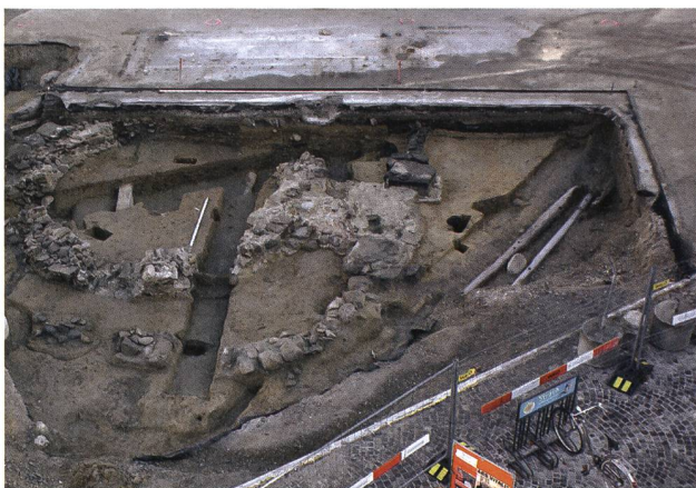
St. Gallen, Gallusplatz, Feld 3 (2011). Die Reste des Rundturms aus dem 8.–10. Jahrhundert. Foto KA SG.
