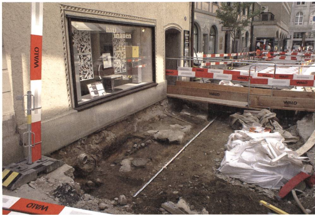
St. Gallen. Westseite Webergasse 2011. Reste von gemauerten Pfeilersockeln von Lauben zeigen die Flucht der mittelalterlichen Gebäude. Foto KA SG.
