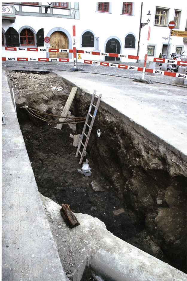
St.Gallen, Gallusplatz 2008. Grabungssituation, Blick gegen Westen. Die dunkle Fundschicht liegt zwischen Leiter und Rohrleitung (Vordergrund). Foto KASG.
