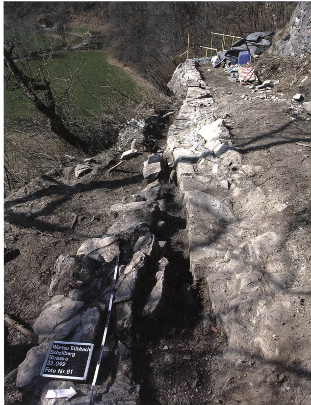
Wartau SG, Alte Schollbergstrasse. Wegstrecke bei der exponierten Stelle an der Hohwand: Eine Stützmauer (rechts im Bild) sichert die Strasse an der steil abfallenden Felskante (ganz hinten im Bild). Sie wurde durch eine jüngere Stützmauer (links im Bild) bei einer Strassenverbreiterung ersetzt. Foto KASG.
