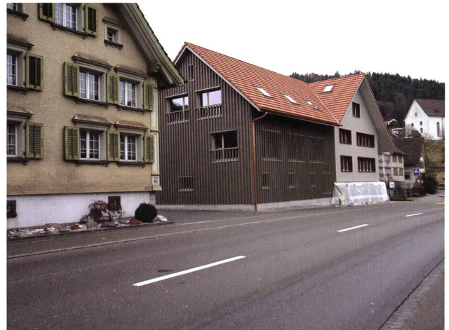
Der nicht geschützte Kreuzfirsthof in der Balgacher Ortsbildschutzzone erhielt 2011 einen (wiederum hölzernen) Ersatzbau für die Stallscheune. Dank des Holzrasters vor den Fenstern erscheint die Strassenfassade des Neubaus schon aus kurzer Distanz als eine geschlossene Fläche. (Foto: Kant. Denkmalpflege)
