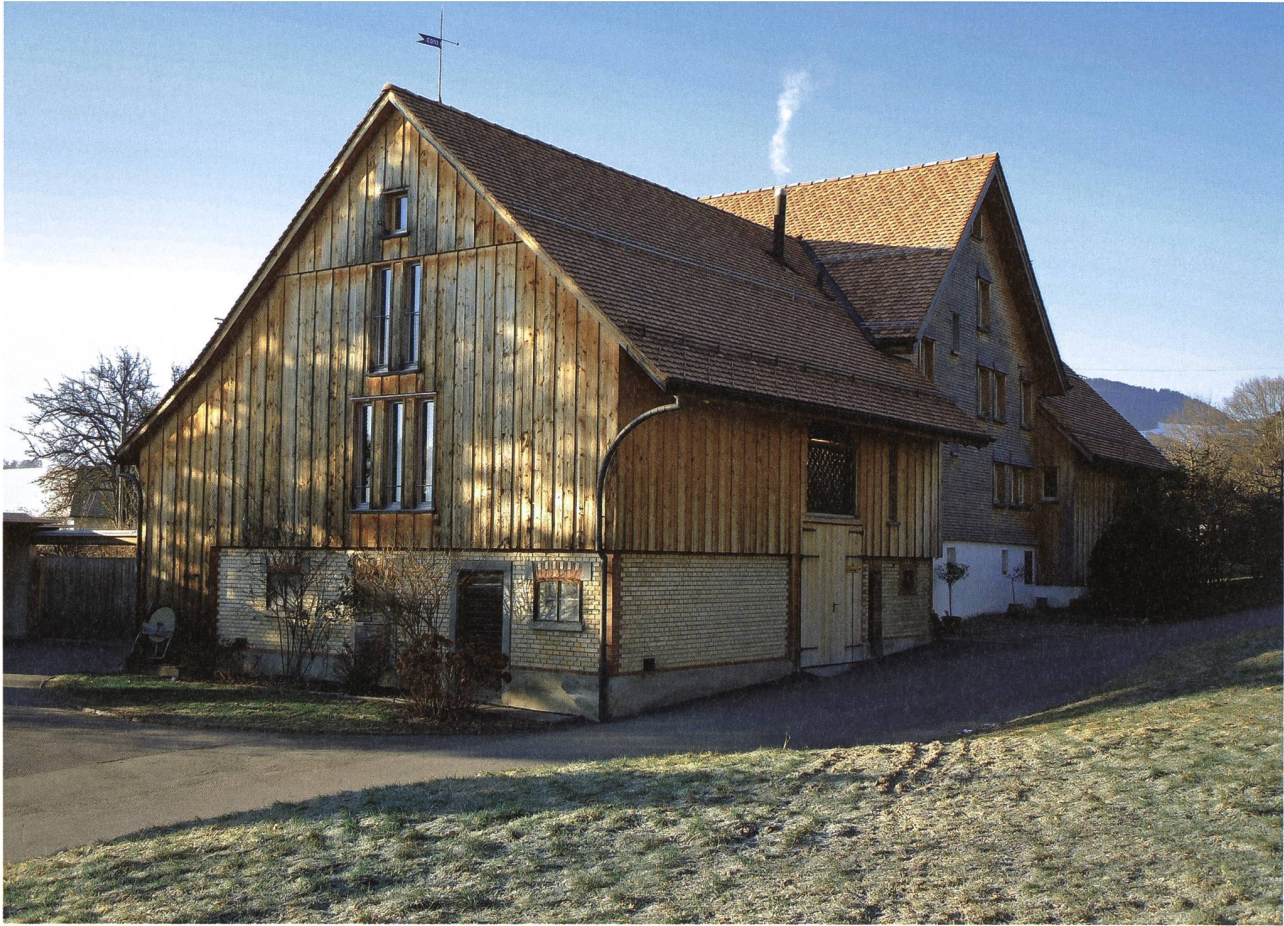
Berneck, Rüden. Renovation des Bauernhauses und Umnutzung der beiden Scheunen durch Architekt Werner Bänziger 2003. Im Sockelbereich ist das Sichtbacksteinmauerwerk mit den Stallfenstern beibehalten worden, im neuen Bretterschirm passen sich die Fenster der Struktur des Holzes an. (Foto: Kant. Denkmalpflege)
