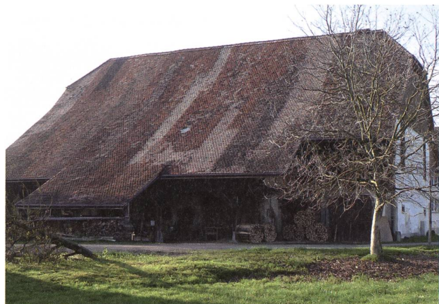
Rapperswil-Jona, Kloster Wurtsbach. Das Dach des Pferdestalls wurde 2004 unter Verwendung der alten Ziegel neu eingedeckt. (Foto: Kant. Denkmalpflege)
