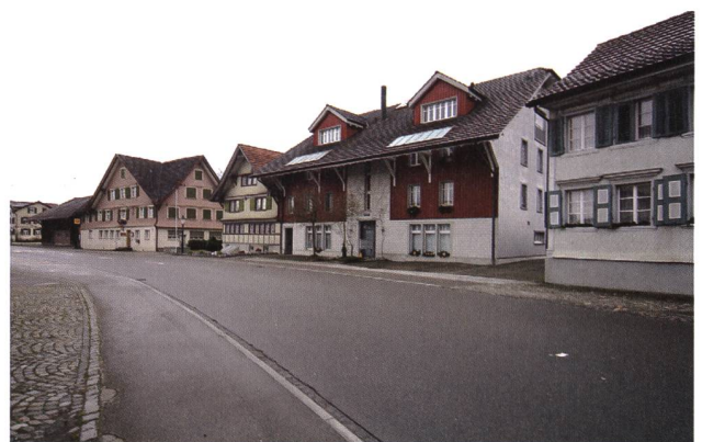
1992 erhielt die Eigentümerschaft die Bewilligung für den Ausbau der Stallscheune im Dorf Oberbüren zu Wohnzwecken. Nachdem ohne Erlaubnis die ganze Scheune abgerissen worden war, entschied man sich für einen volumengleichen Neubau. Während das grosse Vordach noch an die ehemalige Scheune erinnert, führen die Materialisierung mit Kalksandsteinen und die grossen Dachaufbauten zu einem zwiespältigen Gesamteindruck. (Foto: Kant. Denkmalpflege)
