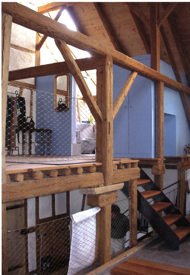
Winterberg und Wangen (ZH). Zwei Beispiele für den Einbau von vertikalen Lichtbändern. Im Gegensatz zur Gaube tritt das Lichtband fast nicht in Erscheinung, die Lichtfülle im Innenraum ist beachtlich. (Foto: Kant. Denkmalpflege)
