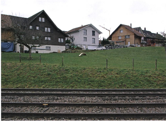
Aus dem geschützten Ortsbild Algetshausen wurde ein Zahn her- ausgebrochen und dabei die Wurzel steckengelassen. Dem stolzen Restaurant Landhaus ist die Stallscheune bis auf ein paar wenige Meter gekappt worden, an ihrer Stelle steht nun ein Fertighaus – und erst noch mit verkehrter Giebelausrichtung. (Foto: Kant. Denkmalpflege)
