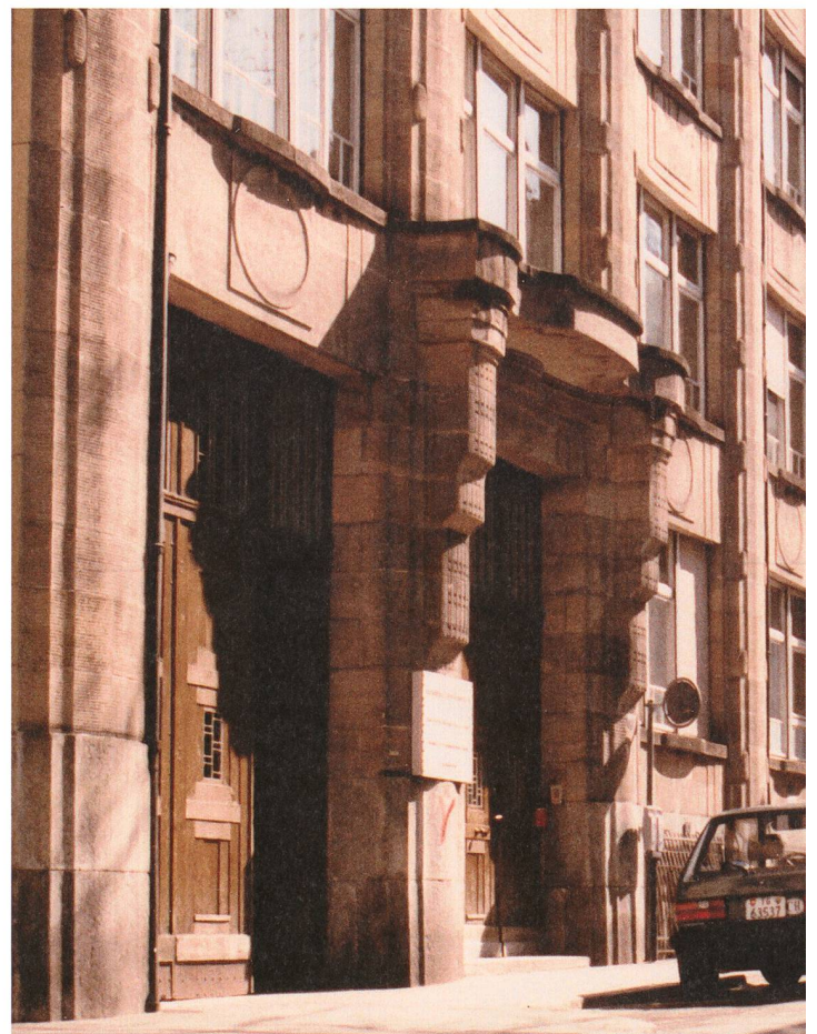
St. Gallen. Ehemaliges Stickereigeschäftshaus Pacific der Herren Zürcher, Niederer & Cie., 1907, Architekten: Curjel & Moser, Zürich und St. Gallen. Ein Riesendampfer im einst klein strukturierten Quartier Bleicheli (heute im Umfeld von «Raiffeisen-City») und der Stadtlounge von Pipilotti Rist. Aufnahme: Peter Röllin.
