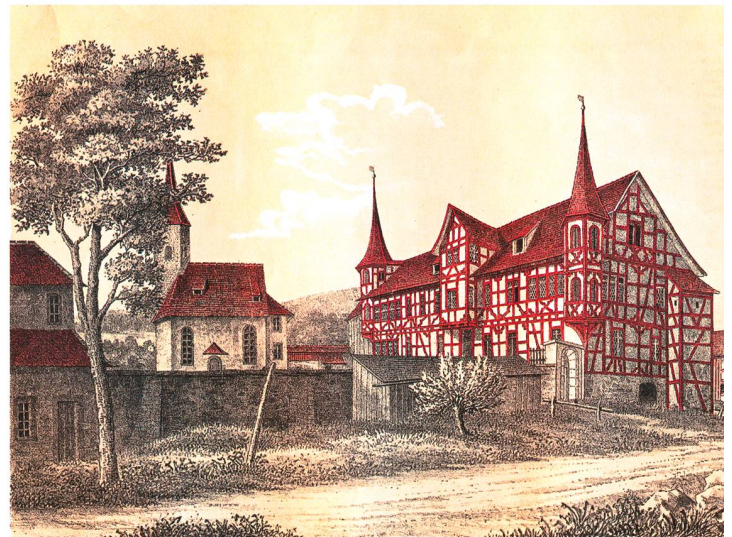
St. Gallen-St. Leonhard. Nonnenhaus (Wohngebäude der Feldnonnen). Die Frauen dieser Samnung leisteten wichtige soziale Dienste (v. a. im Bereich des Funeralwesens und der Krankenpflege). Geleitet durch ihr Selbstverständnis wehrten sie sich während des Vollzugs der Reformation auf Stadtgebiet entsprechend gegen die Forderung der Stadt nach Auflösung ihrer Gemeinschaft und ihres Hauses. Vadian betrieb diese Auflösung aktiv, Kessler opponierte zumindest nicht dagegen. Lithographie von J. Tribelhorn, St. Gallen, um 1868. Quelle: NjblSG 8 (1868), Frontispiz.
