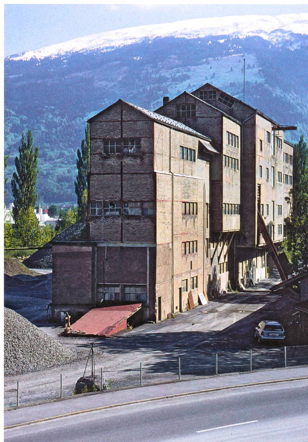
Aufbereitungsanlage Malerva, Sargans. Hier wurde das Eisenerz aus dem Gonzen gebrochen, klassifiziert und sortiert direkt auf Eisenbahnwagen verladen. Foto: Kantonale Denkmalpflege 2005.
