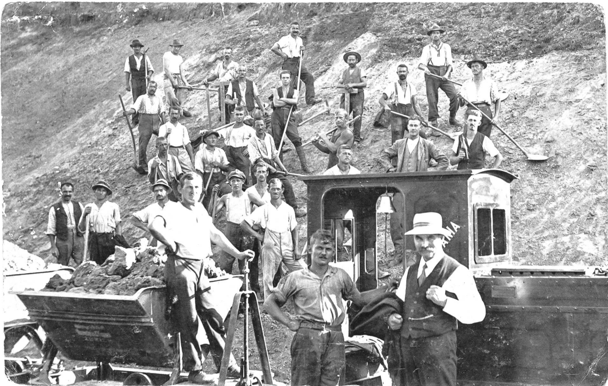
Bau BT bei Degersheim, so lautet die Bleistiftnotiz auf der Bildrückseite. Das Foto gehört aufgrund der Machart und Gebrauchsspuren zweifellos zu den begehrten Erinnerungen an die Arbeit – und den gemeinsam geleisteten Einsatz. Kleider der Arbeiter und die Baustellenlokomotive «MONTANIA» sind plausibel für die Zeit um 1910. Eine Lokalisierung ist allerdings noch nicht möglich, denn vergleichbares Bildmaterial fehlt derzeit. Die Petrol- bzw. Rohöl-Lokomotiven waren damals derart selten, dass auf eine genauere Lokalisierung mittels Bildvergleichen gehofft werden darf. Slg. A.Heer.
