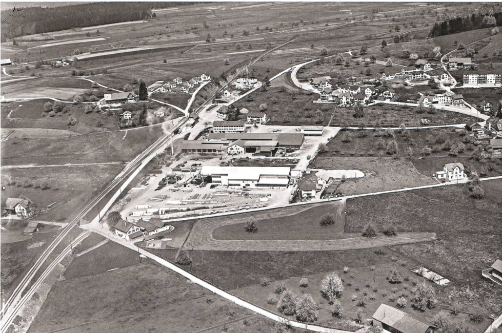
Die Luftaufnahme wurde der Region Zürich zugeschrieben. Der Abgleich mit der Landeskarte liess anfänglich einen Werkplatz mit Gleisanschluss bei Niederhasli vermuten. Zu viele Widersprüche blieben bestehen. Aufnahmezeitraum, fehlende Fahrleitungen am Bahntrasse, die erahnbaren Architekturen des Stationsgebäudes und der umliegenden Bauernhäuser sind eher Indizien für eine Station der Mittelthurgaubahn. Strassenzüge und Wohnbauten sprachen eigentlich für Bettwiesen. Der Werkplatz mit den umfangreichen Gleisanlagen als zentral errichtetes Indiz fehlten hingegen auf allen Generationen der Landeskarte. Letztendlich blieben zwei Schlüsse: Im Bild ist tatsächlich Bettwiesen, die Landeskarte 1:25 000 wurde jedoch mangelhaft nachgeführt. Slg. Bildarchiv ETHZ.
