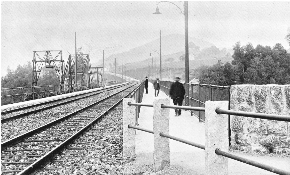
Ansicht einer Eisenbahnbrücke – aber wo? Die Situation im Bild erinnert flüchtig an die SBB-Brücke über die Sitter bei Bruggen. Einzelheiten lassen Aktivitäten, Ort und Aufnahmezeitpunkt überraschend genau beschreiben. Der Fussgängersteg spricht für die Sitterbrücke, Fahrleitungen fehlen, aber die Masten stehen. Im Hintergrund ist eine eigenartige, ja rätselhafte Konstruktion erkennbar. Das Bild zeigt tatsächlich die neu eröffnete, doppelspurige SBB-Brücke, und im Hintergrund ist das Abbaugerüst für die alte Sitterbrücke erkennbar. Die Aufnahme muss aus dem Spätsommer oder Herbst 1926 stammen. Slg. Bildarchiv ETHZ.
