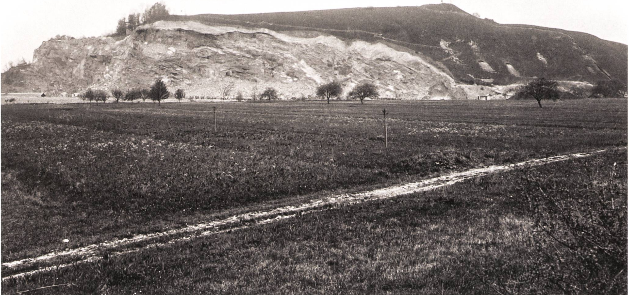
Steinbruch der Internationalen Rheinregulierung, 3. Mai 1913, von Nordwesten. Vor der Sprengung wurde an der oberen Kante die Erde entfernt; dabei kamen unter anderem auch die Bernsteinperlen und -knöpfe zum Vorschein. Der Abschlusswall im Westen des Hochplateaus ist deutlich sichtbar. StASG A 481/03.01-02.
