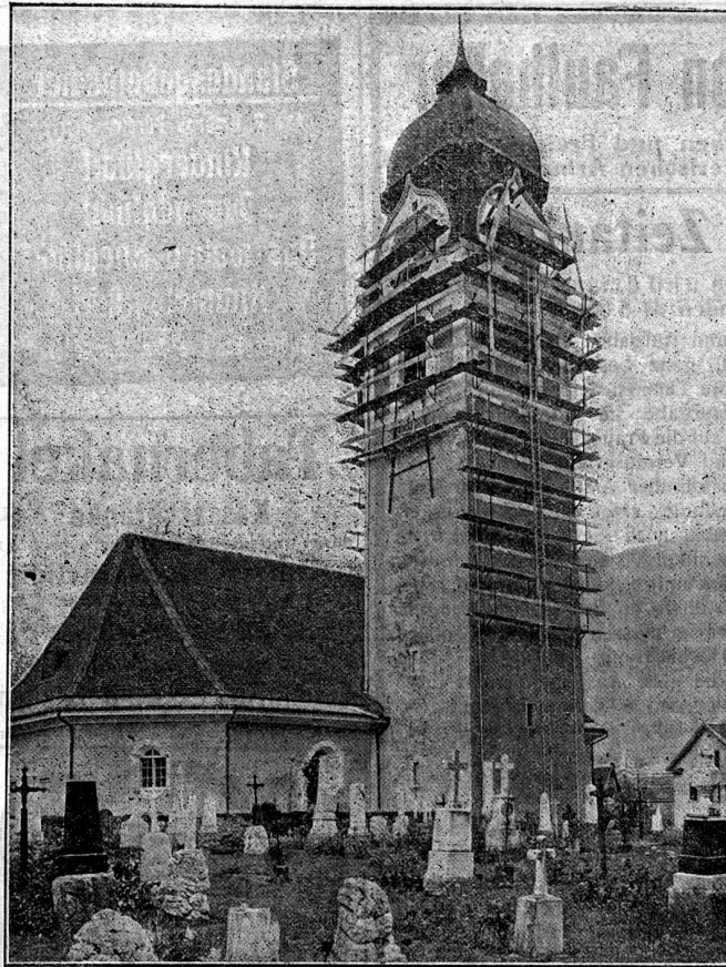
Turm-Gerüst, System „Blitz“ (für Uhr und Verputz-Reparaturen)
