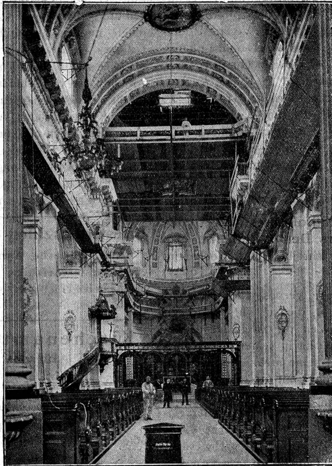
S. J. J. rsen-Kirche, Solothurn, mit „Blitz“-Gerüste eingerichtet, absolut freier Verkehr
