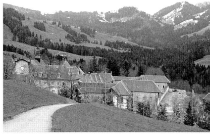
Foto von der Kartause im April 2006. Der komplette Flügel auf der Talseite ist abgerissen und eingeebnet. (Bild: Ciric)
