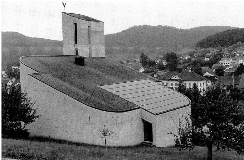
Ref. Kirche Bubendorf/BL. Jahresproduktion rund 14500 kWh. Die Anlage gewann den Baselbieter Solarpreis 1997 für besonders gelungene Integration ins Gebäude.
