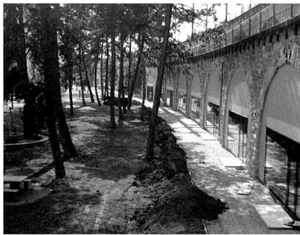
Im Zürcher Lettenviadukt entsteht "jenseits" eine Kirche für junge Leute.
