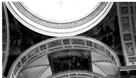
Nach den Arbeiten: Alles leuchtet hell.
