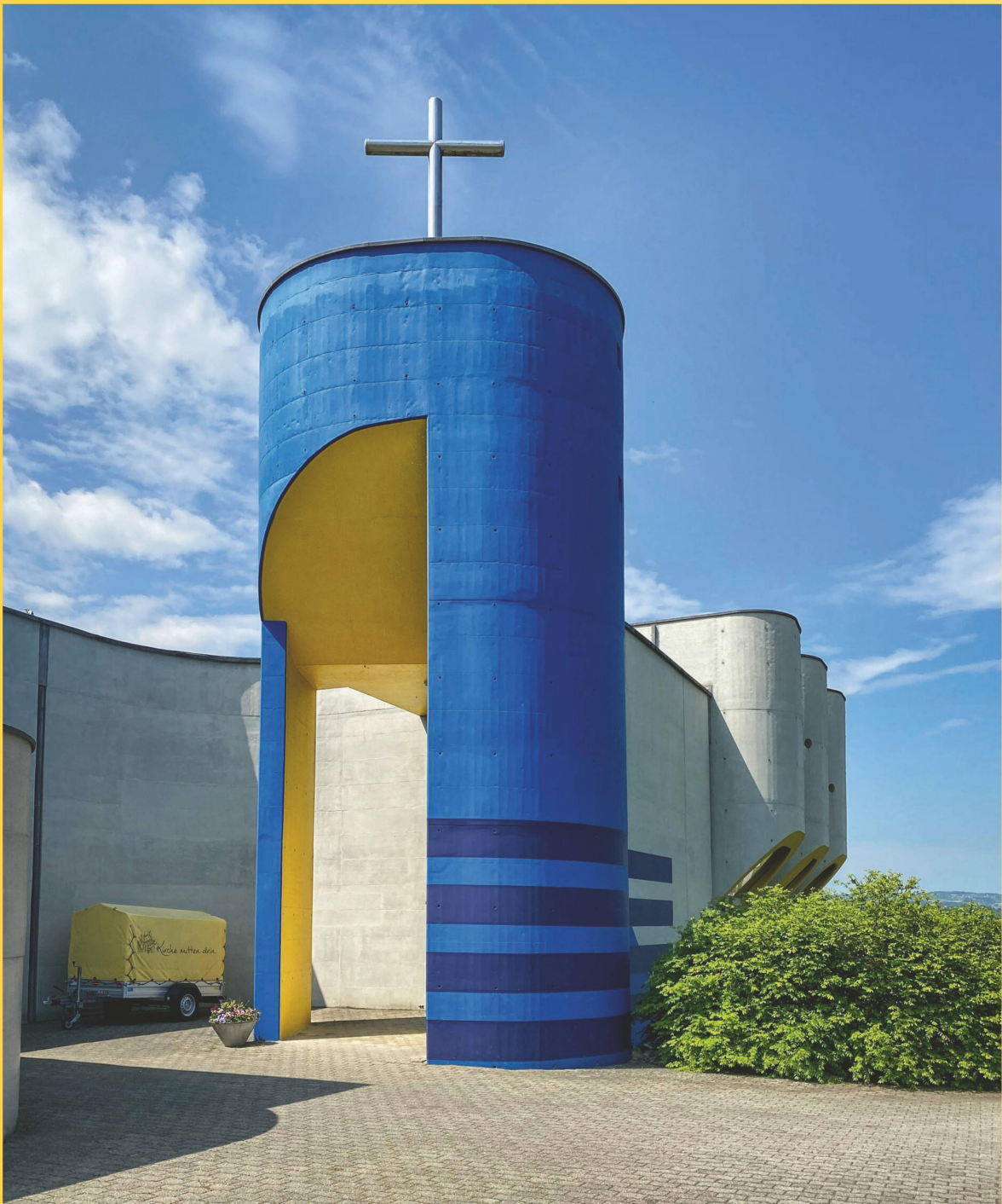
Das Kirchenzentrum St. Agatha in Buchrain LU des Architekturbüros Studer Studer Naef (1970–72). Hier der Eingang zur Kirche. Das Kreuz wurde erst nachträglich angefügt, um die Kirche als Kirche erkennbar zu machen.
