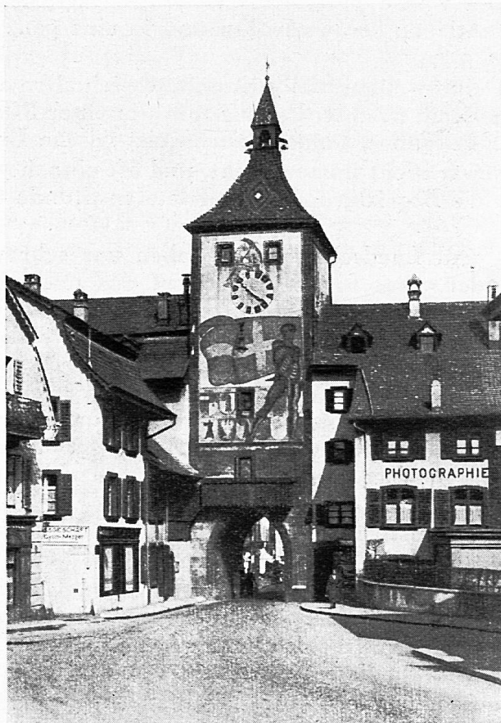
Liestal Tor, Außenansicht
