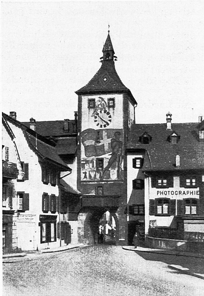
Liestal Tor, Außenansicht
