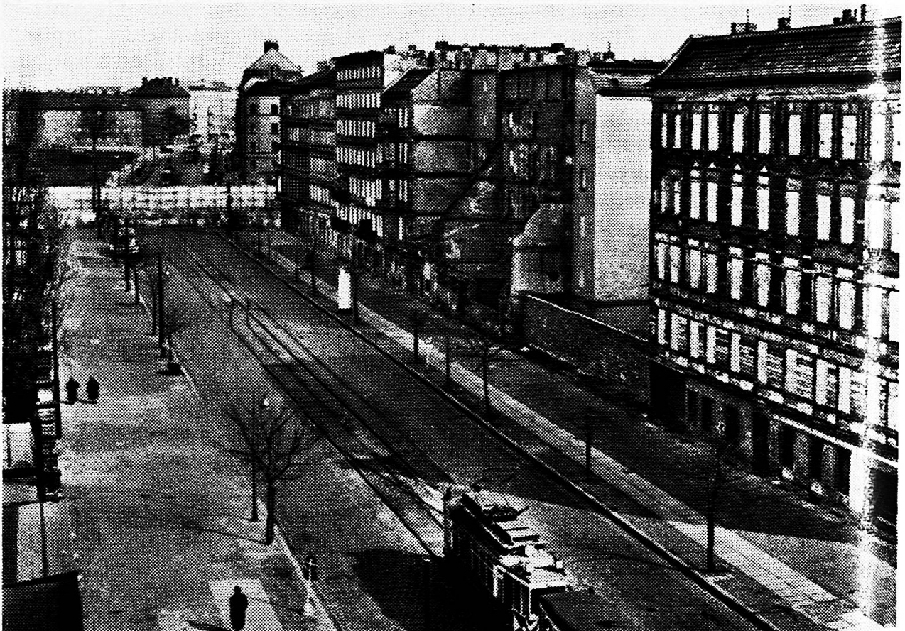
Die Bernauerstraße. Die Häuser rechts bilden die Zonengrenze. Die Häuser sind geräumt, die Fenster zugemauert.
