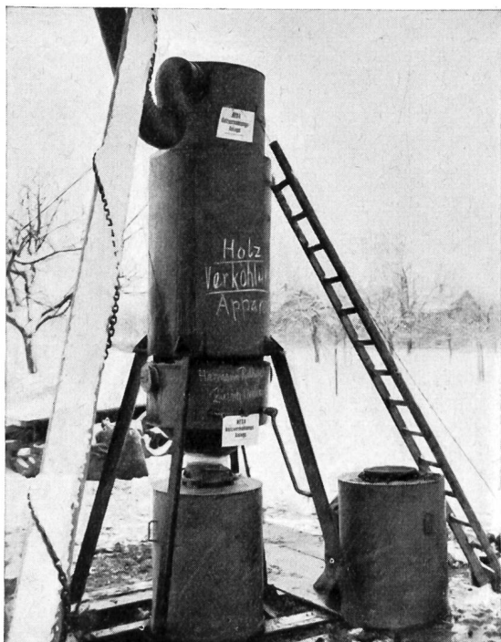
Holzverkohlungsanlage Rathgeb Oerlikon
