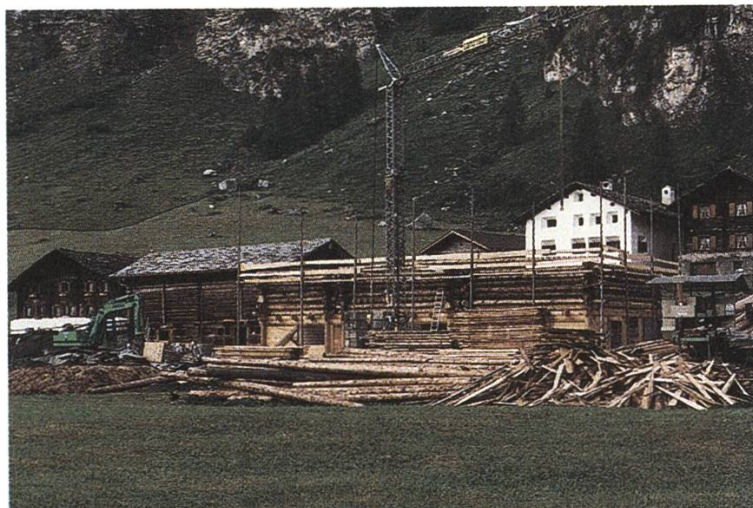
Stallneubau im Avers GR: Landschaftlich angepasste Bauweise in Rundholzkonstruktion (ohne Finanzhilfen des Bundes)
