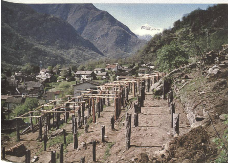
Reconstruction de la vigne en terrasses « Canton » à Maggia TI
