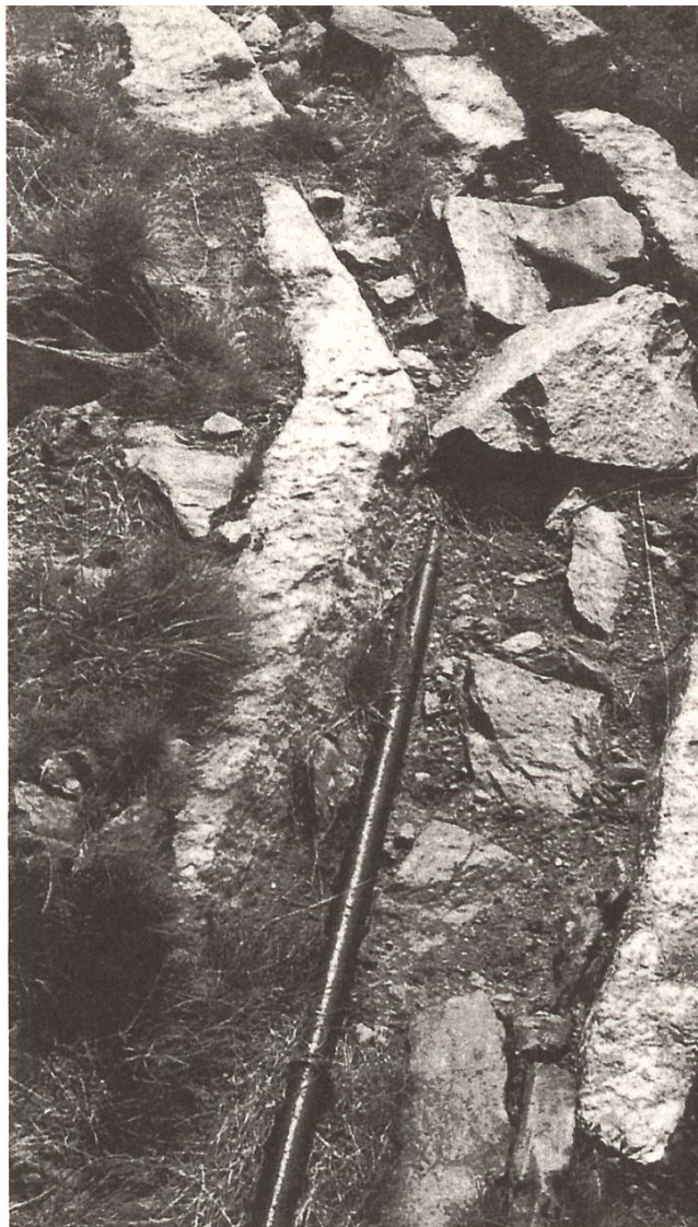
Die Erneuerung der Wasserleitung auf der Alp Vaccariscio TI
