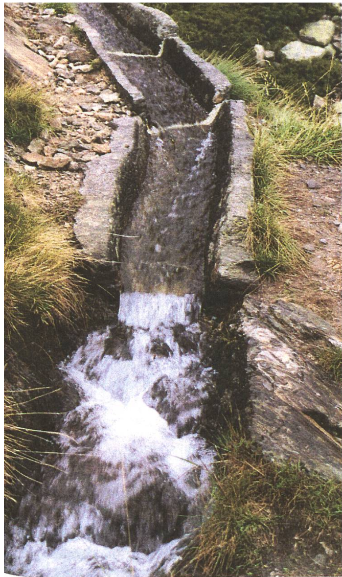
La rénovation des canaux de pierre sur l'alpe de Vaccariscio TI
