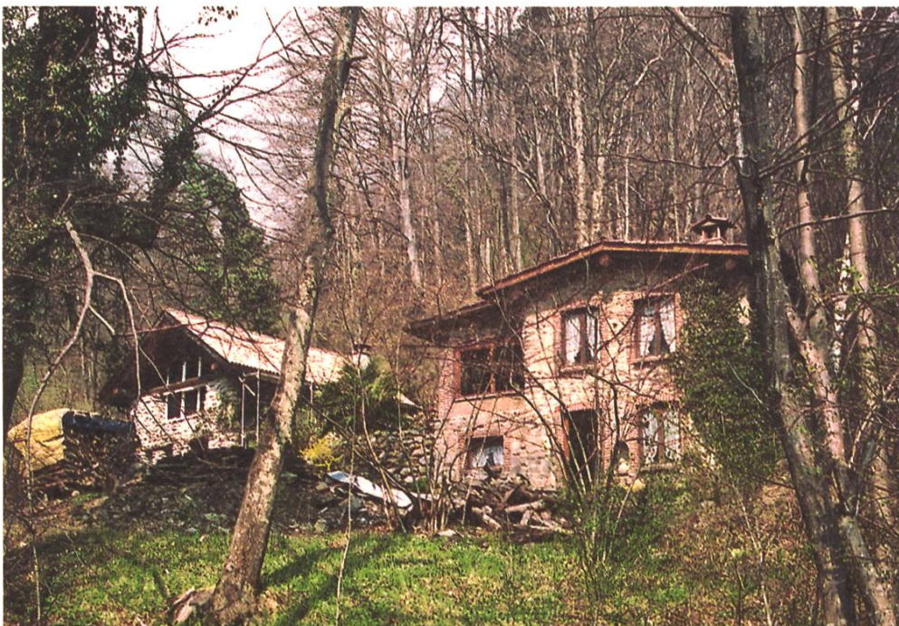
Umgebaute Rustici im Wald (Novaggio TI)
