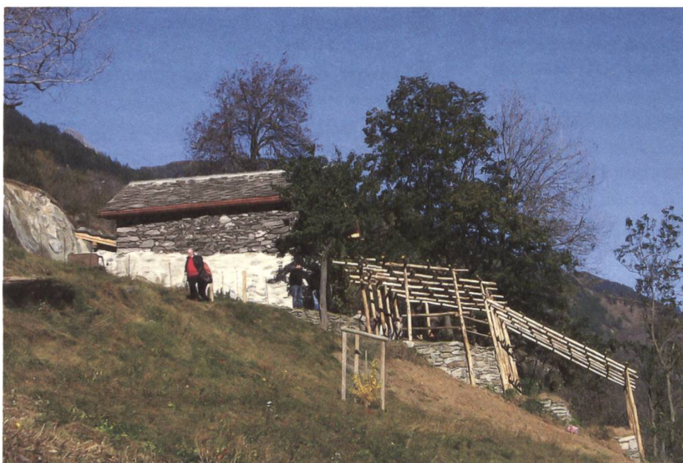
Der restaurierte Bau mit Pergola in der Kastanienselve Salzgäb/Mörel VS
