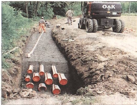
Es geht auch ohne Masten: Bau der Hochspannungsleitung bei Mendrisio im Jahr 2007.
