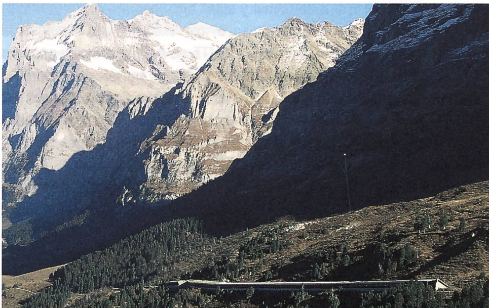
Der markierte 60 Meter hohe Mast der V-Bahn vor der Eigernordwand
