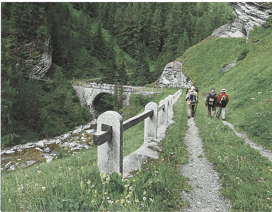
Alte Averserstrasse mit Natursteinbogen- brücke und Stein- säulen bei der Crester Rheinbrücke
