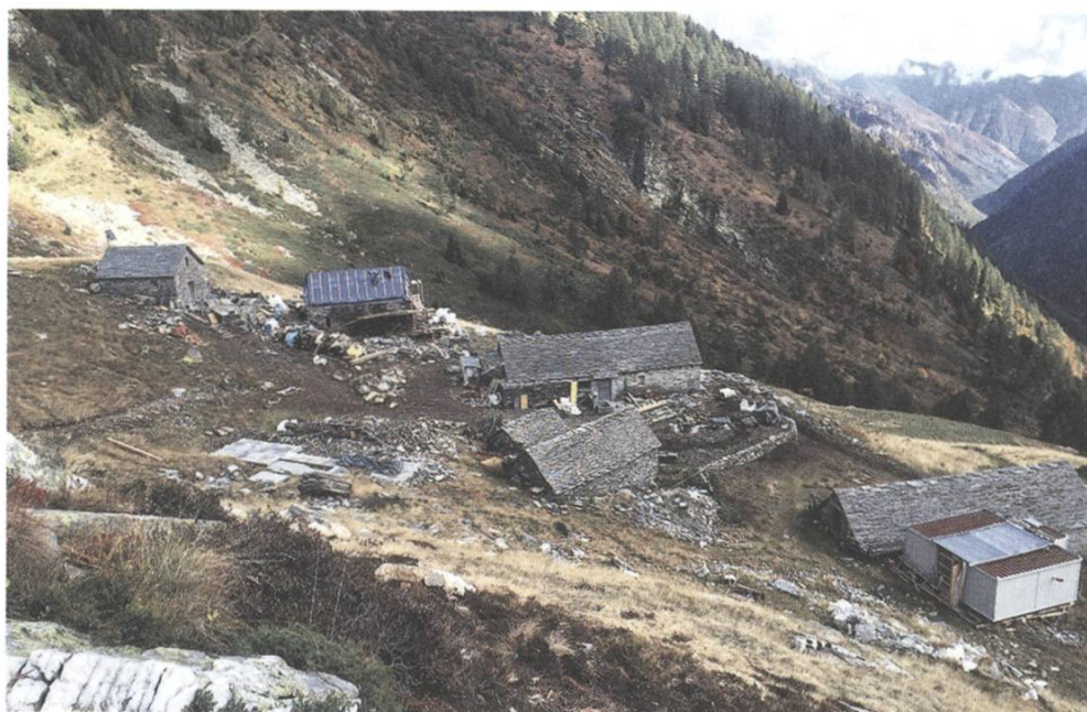
Erneuerte Alpgebäude auf der Alpe Porcaresc
