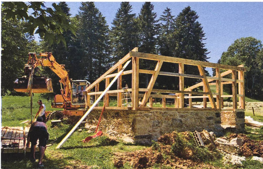
Restaurierung einer Zisterne bei Le Vion, Sonceboz- Sombeval BE
